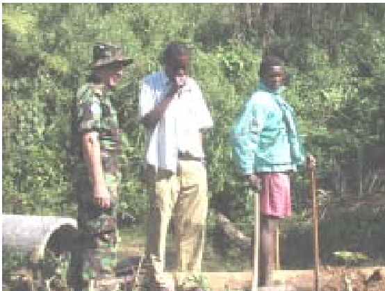
Le Lieutenant-colonel Walker inspectant les travaux de réfection d'un pont en compagnie de Kakule, Chef de Muhanga (Photo Sébastien Lapierre/MONUC)
