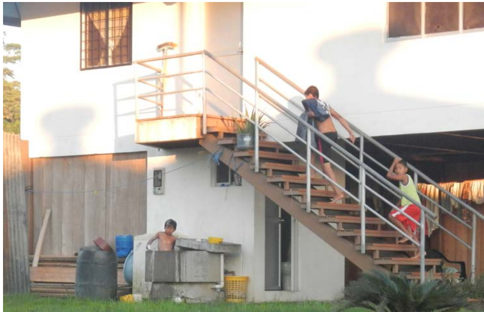
Figura 13 | Adecuaciones con madera en el 1er piso y rejillas en ventanas, 2015
