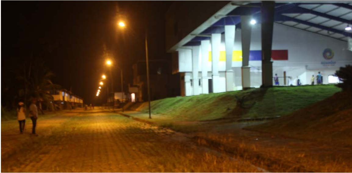
Figura 6 | Luminarias y coliseo deportivo Pañacocha, 2015
