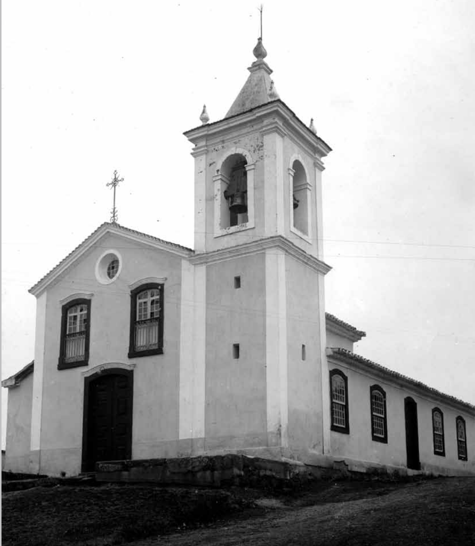
Igreja de Nosso Senhor do Monte. Construída nas proximidades de locais de mineração, está um pouco afastada do núcleo urbano original. Fotografia: 1943.
