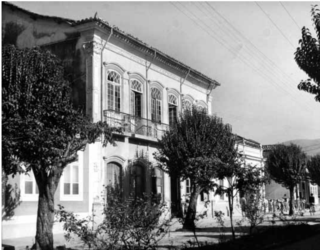
Delegacia fiscal. Em frente, a praça rebatizada com o nome de Frei Orlando. Fotografia: Augusto Carlos da Silva Telles, 1964.
