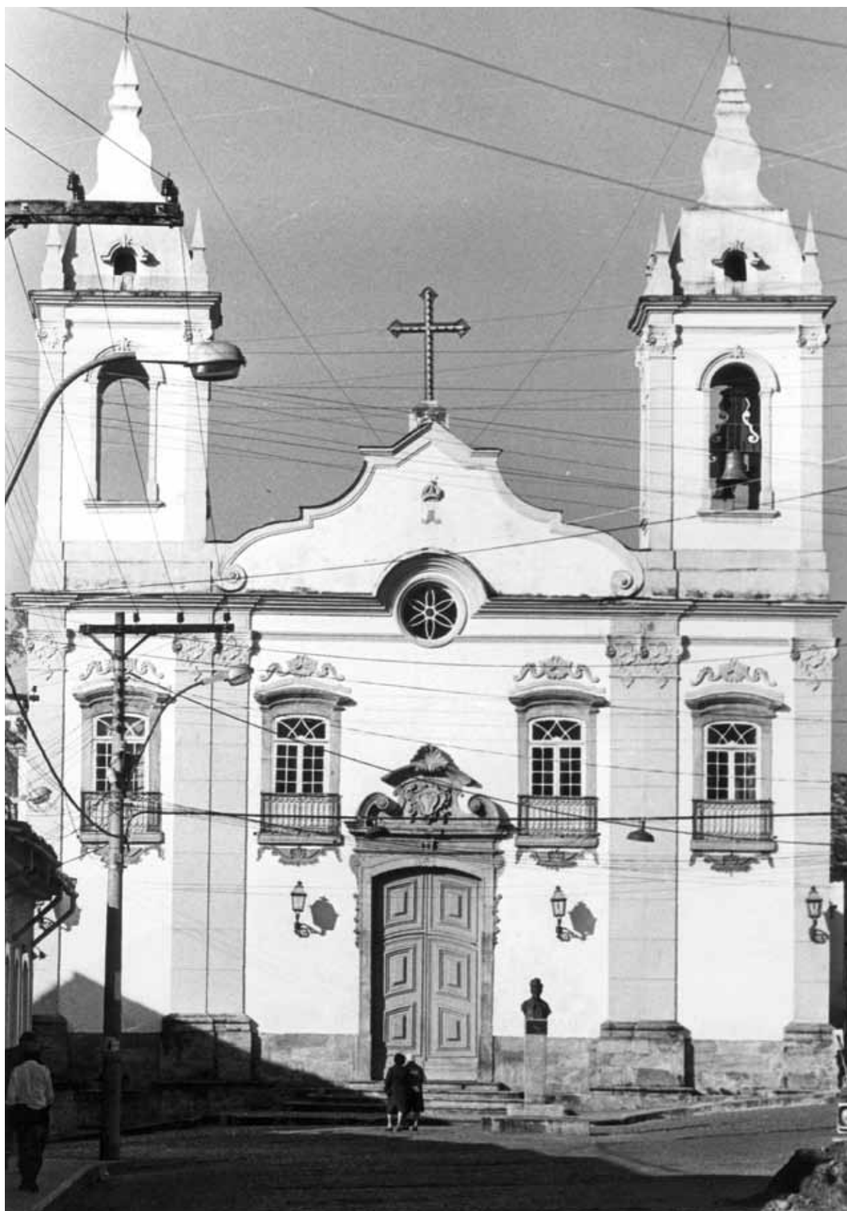
Fachada da Igreja de N. Sra. do Rosário, construída pela irmandade criada em 1708. A fiação elétrica foi removida posteriormente. Fotografia: Renato Morgado, 1980.
