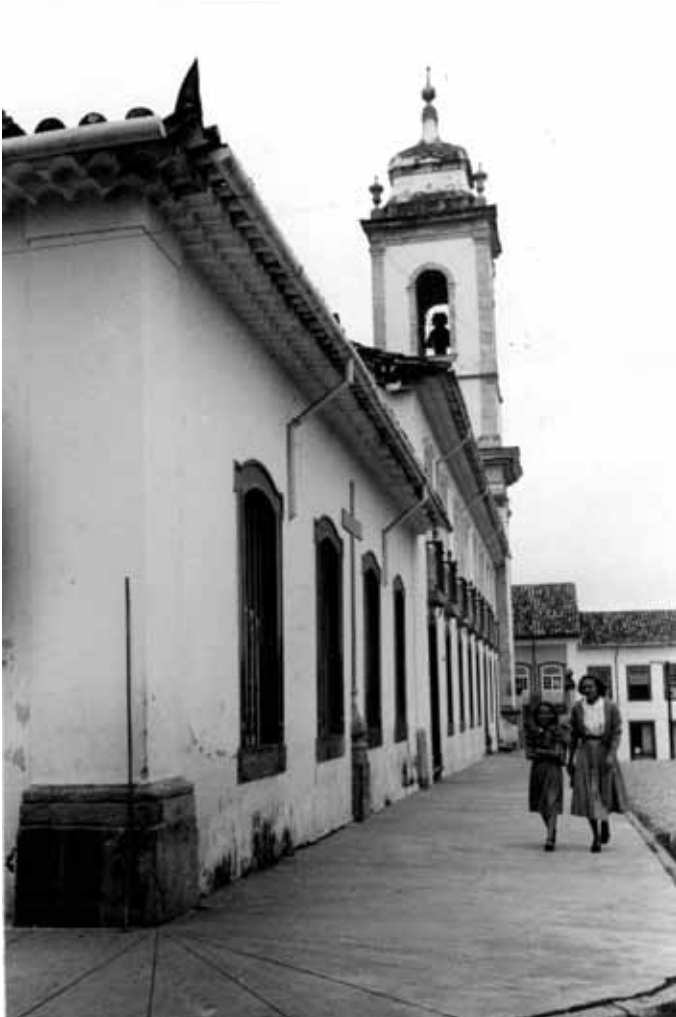
Vista dos fundos da Igreja do Pilar, mostrando o beiral, feito com massa e moldado na forma de telhas capa e canal, e o calçamento em cantaria lavrada em forma de leque nos ângulos. Fotografia: Arthur Arcuri, 1950.
