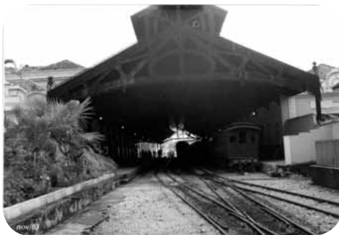
Fachada posterior da estação de São João del-Rei. Fotografia: 1983.
