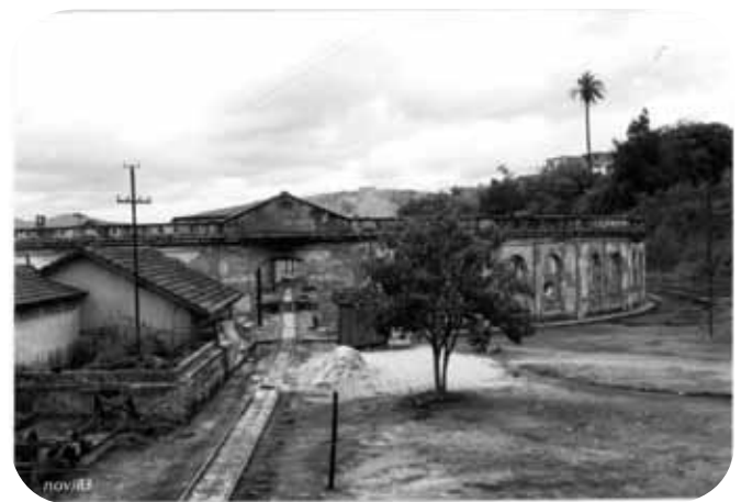
Rotunda. Vista exterior, vendo-se a linha central para entrada de locomotiva no girador. Fotografia: 1983.
