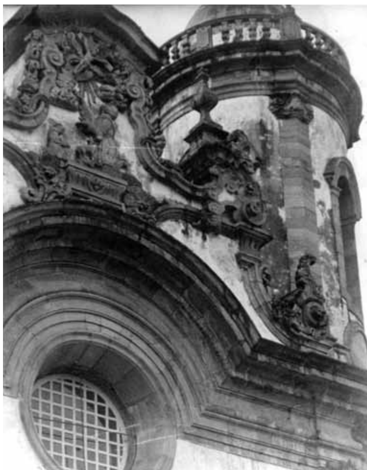
Torre e óculo na fachada da Igreja de São Francisco de Assis, construída a partir de 1774. Projeto de Antônio Francisco Lisboa, o Aleijadinho. Fotografia: Nestor, s/d.
