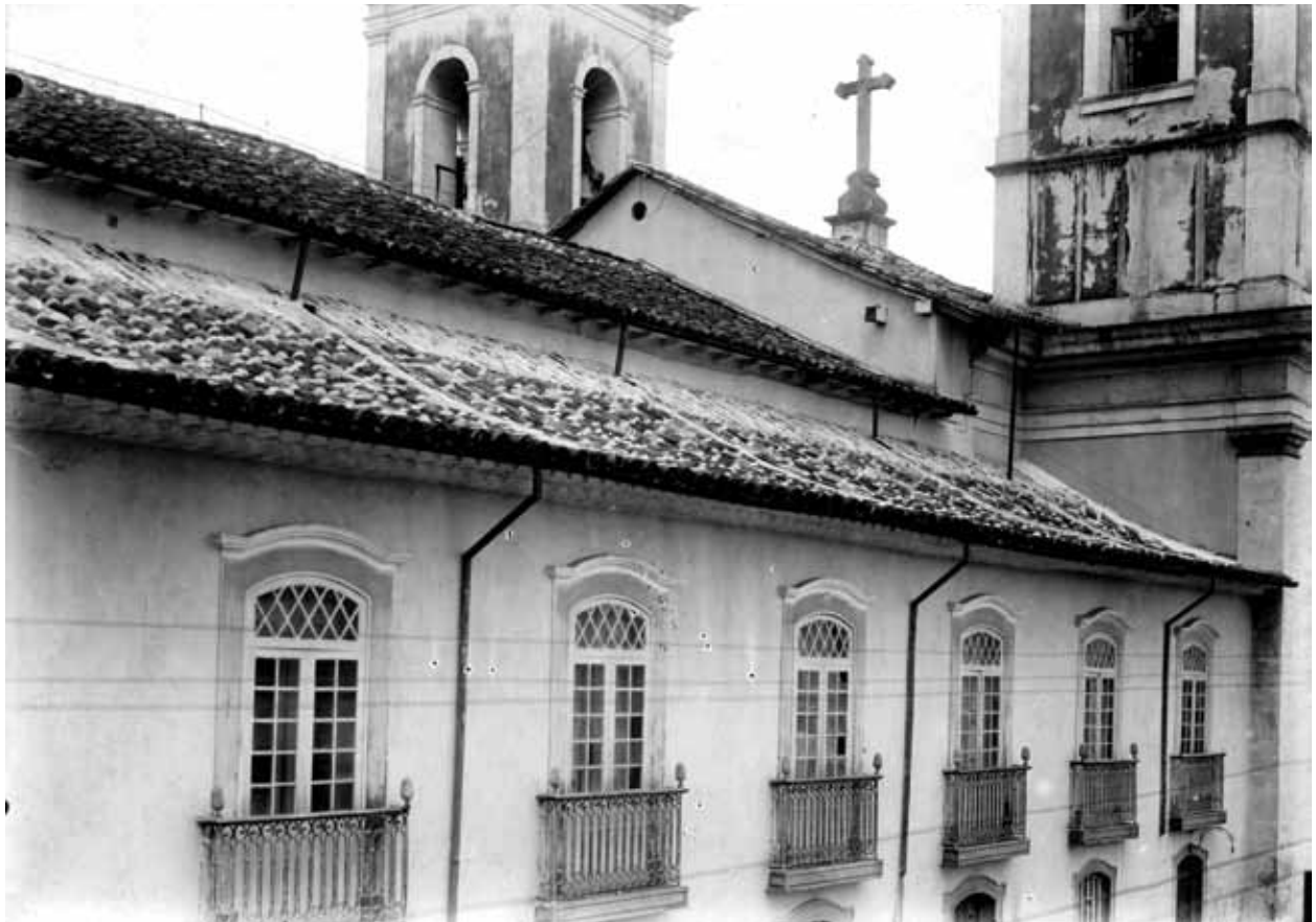
Janelas externas da galeria da Igreja Matriz de N. Sra. do Pilar, com as calhas rentes aos beirais do telhado. Fotografia: 1945.
