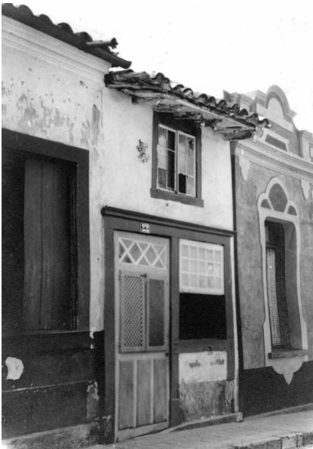
Casario na Rua Rezende Costa. Fotografia: s/d.
