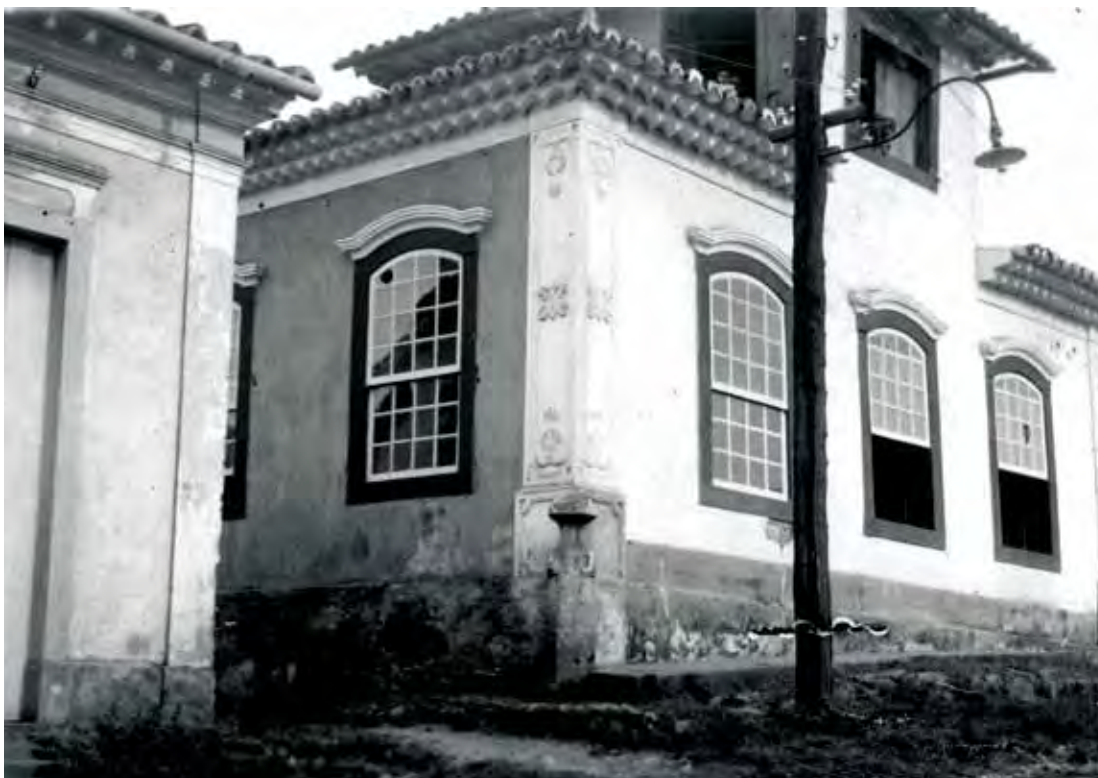
Sobrado urbano, com detalhe dos cunhais em cantaria lavrada artisticamente. Fotografia: Arthur Arcuri, s/d.
